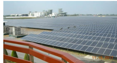
太陽光発電の現場
